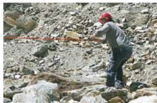
12 Il dispositivo viene attivato a distanza di sicurezza per mezzo della fune: l'operatore deve indossare elmetto, cuffie protettive, occhiali protettivi e scarpe antinfortunistiche.
