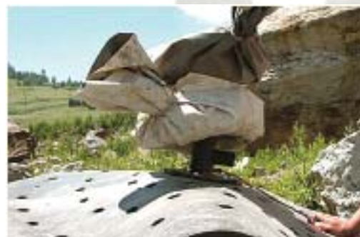
10 Rock Cracker viene stabilizzato mediante sacchi di sabbia.
