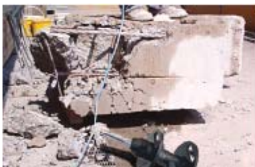
Oltre alle classiche applicazioni nella roccia, Rock Cracker è ideale per la frantumazione di fondamenti in cemento armato, anche all'interno di edifici.
