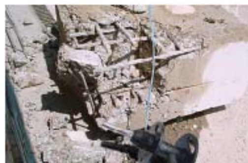
Rock Cracker è in grado di frantumare facilmente il cemento armato.
