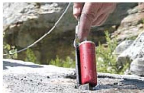
**4** Sécurité : La cartouche Cracker est introduite dans le trou à l'aide d'une cuillère de récupération. Cela permet de la retirer sans problème après le tir et d'empêcher de laisser en place des cartouches non détonées.
