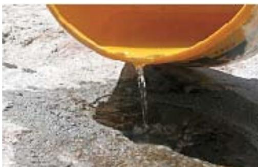
**3** Le trou est ensuite rempli d'eau. Quand la pierre est poreuse, du gel est utilisé pour l'étanchéification.
