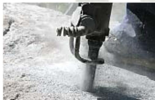
**2** Un trou de 32 mm de diamètre est percé. Avec le Rock Cracker, nous avons la possibilité de travailler avec des tailles de trous de 28 à 45 mm de diamètre.
