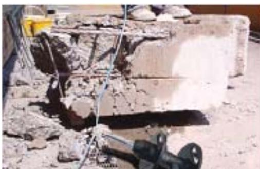
Outre les utilisations classiques sur les blocs de rocher, le Rock Cracker peut également être utilisé pour casser des fondations en béton armé, même à l'intérieur de bâtiments.
