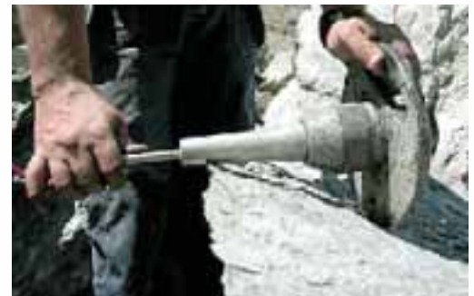
14 Mit Hilfe eines Patronenauswerfers wird der Starter wieder entfernt.
