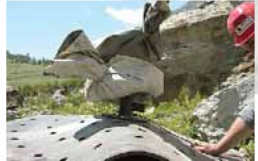
10 Der Rock Cracker wird mit Sandsäcken beschwert.
