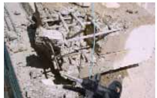
Stark armerierter Beton kann ohne Probleme mit dem Rock Cracker gespalten werden.
