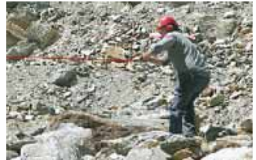
12 Aus sicherer Distanz wird mit der Abzugsschnur die Spaltung ausgelöst. Sicherheit: Das Tragen von Helm, Ohrschutz, Schutzbrille und Sicherheitsschuhen ist obligatorisch.
