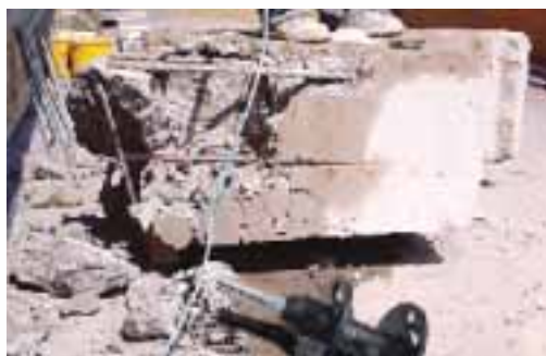
Nebst den klassischen Anwendungen im Fels eignet sich der Rock Cracker für das Spalten armerierter Betonfundamente, auch innerhalb von Gebäuden.
